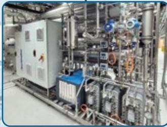
Réalisation du plus grand **dispositif de traitement d'eau à usage pharmaceutique** à ce jour avec une capacité de 24 m<sup>3</sup>/h.
