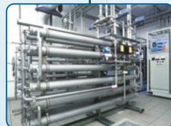
La première installation d'osmose inverse avec un **rendement de plus de 90 %** est réalisée à l'EPF de Zurich. Cette installation se démarque par ses économies d'eau et son efficacité énergétique et pose de nouveaux jalons dans le traitement durable de l'eau.
