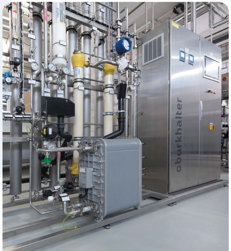
Ultrafiltration (bildmässig mit gelben Endkappen) als Endstufe einer kalten WFI-Erzeugung
