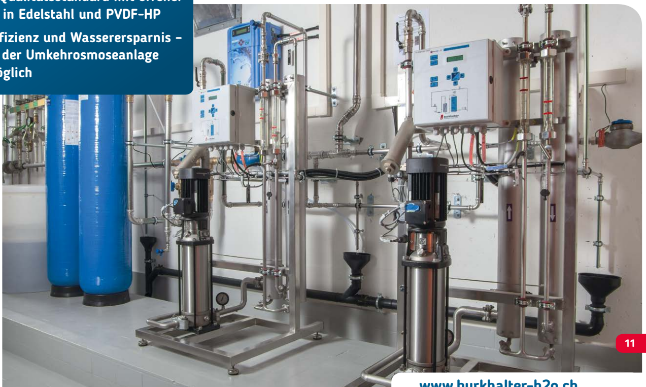
Typische Gebäude- wasseraufbereitung mit Enthärtung und Umkehrosmose
