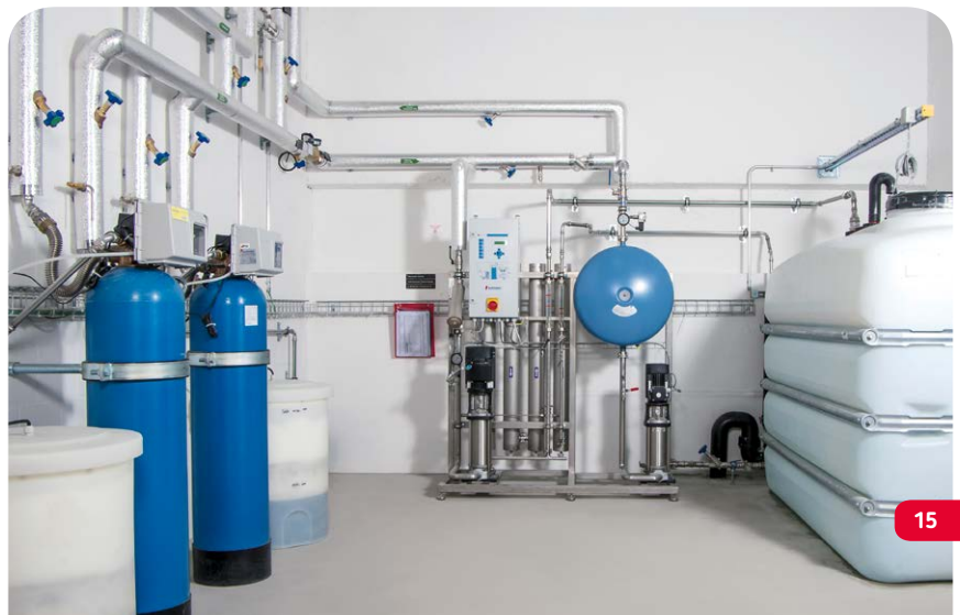
Umkehrosmoseanlage mit Druckerhöhung der Serie Power
