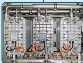
Realisierung der **ersten Reinstwasseraufbereitung** mit dem Verfahren der Elektrodeionisation.
