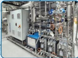
Realisierung der bisher grössten thermisch sanitisierbaren **Pharma-Wasser-Anlage** mit einer Leistung von 24 m<sup>3</sup>/h.
