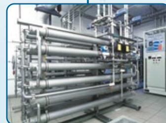
An der ETH Zürich wird die erste Umkehrosmoseanlage mit einer **Ausbeute von mehr als 90%** realisiert. Diese Anlage hebt sich durch ihre Wasserspar- und Energieeffizienz hervor und setzt neue Maßstäbe in der nachhaltigen Wasseraufbereitung.
