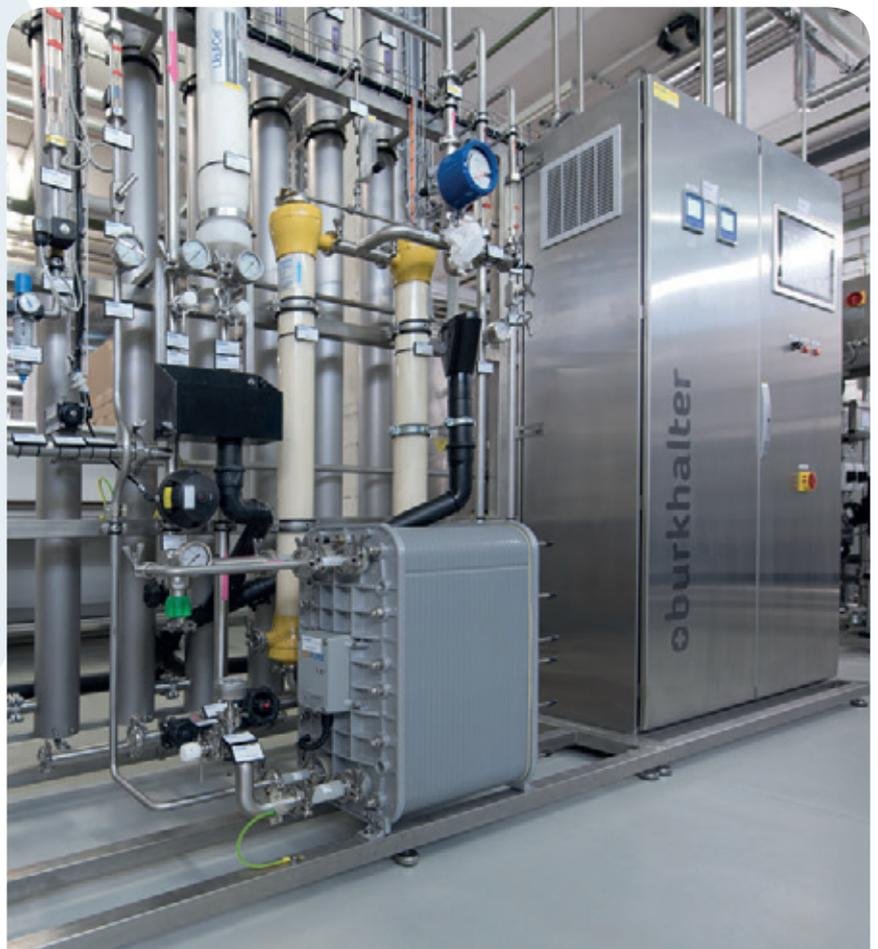
Ultrafiltration (bildmitten mit gelben Endkappen) als Endstufe einer kalten WFI-Erzeugung
