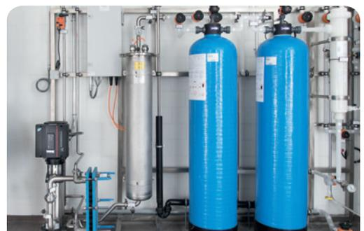
Verteilung mit Druckerhöhung, Wärmetauscher, UV-Anlage, Polisher und Mikrofilter für Ultrapure Water
